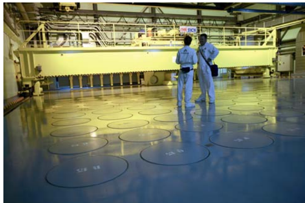
Figure 7 : Entreposage de colis CSD-V – AREVA La Hague
